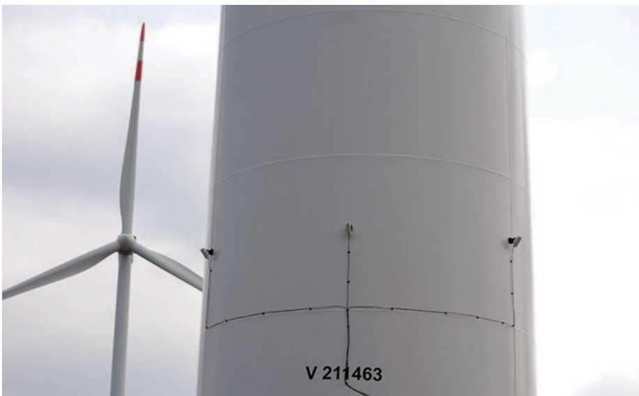
Sechs industrielle Farbkameras mit Auflösungen von 6 oder 20 Megapixel in wetterfesten Schutzgehäusen am Mast eines Windrads nehmen Bilder auf, um den Luftraum rund um das Windrad zu überwachen.
